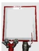
Compuesta por marco-contramarco IPF-40 (para empotrar) ó Cofre IPF-40 (para superficie o empotrar) metálico pintado en rojo de medidas **645 x 590 x (300) mm** con puerta pintada para cristal (no incluido) y cierre de cuadrado de 8 mm. Bifurcación 45 mm. con válvulas, Entrada 2 1/2" x 2 Salidas de 45 mm. tipo barcelona UNE-23400 en aluminio estampado, con tapones. Y Válvula de sección de latón de 3".
